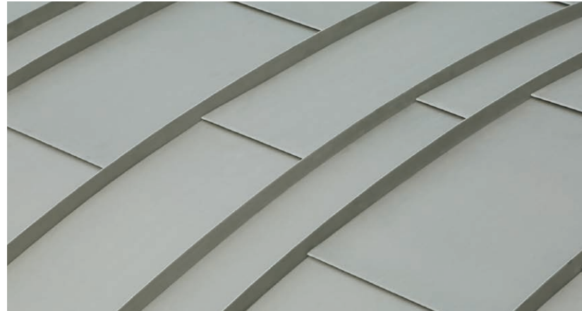
豎平葺きアーチ
